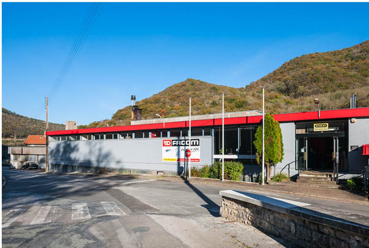
Entrée des bureaux.
