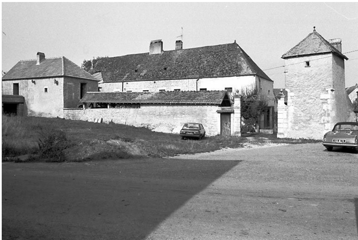
Ferme située Grande Rue à Vantoux.
