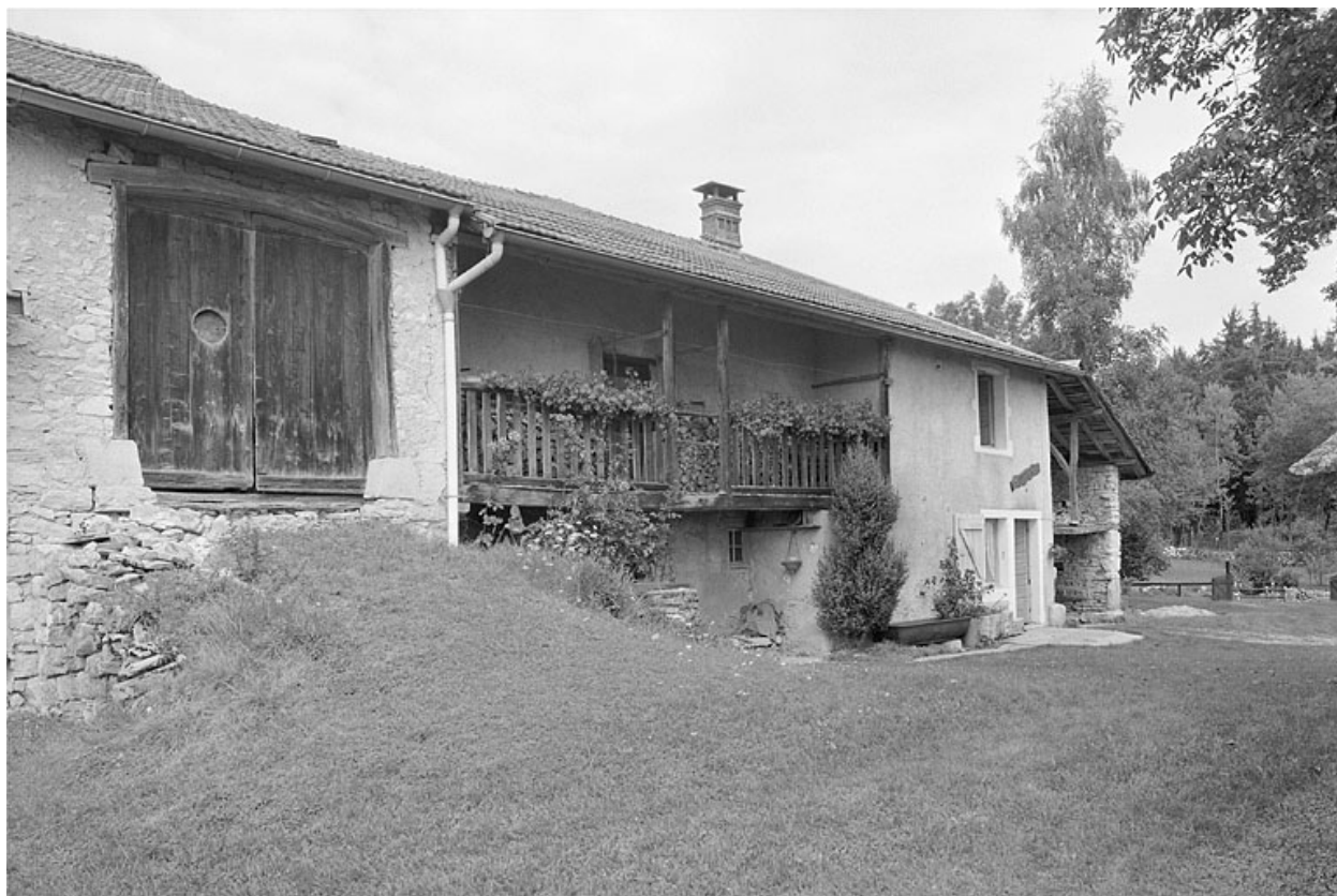
Façade antérieure, balcon en galerie.
