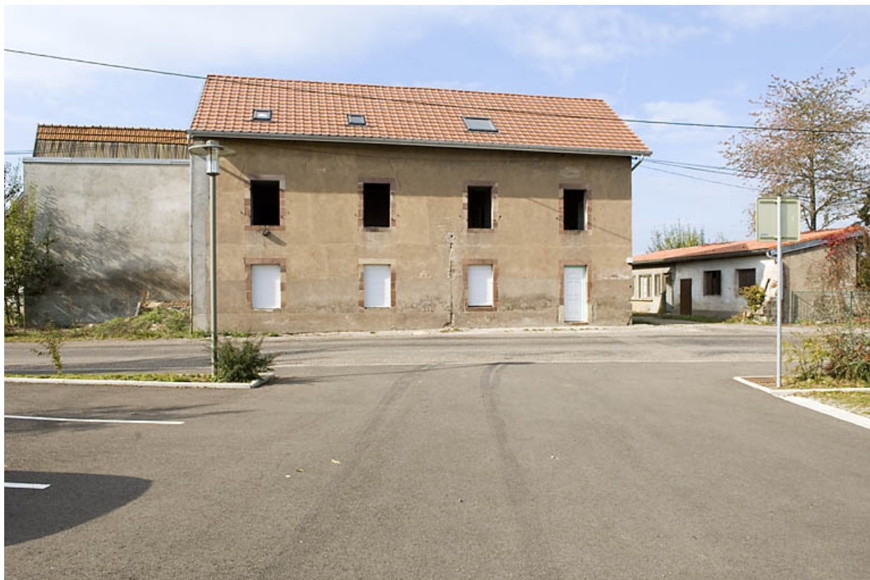
Ancien atelier de fabrication (?). Façade sur rue.
