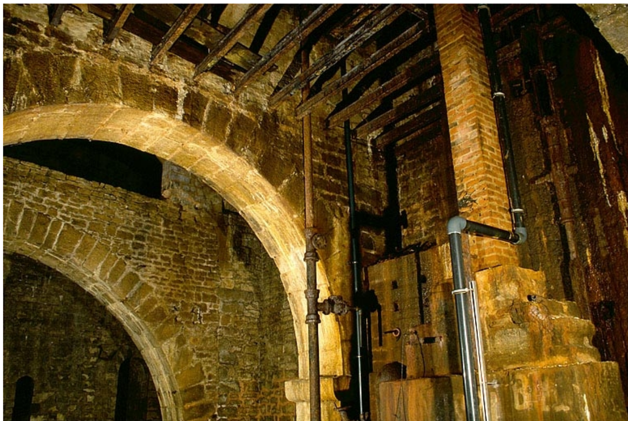
Parties supérieures du puits à Muire.
