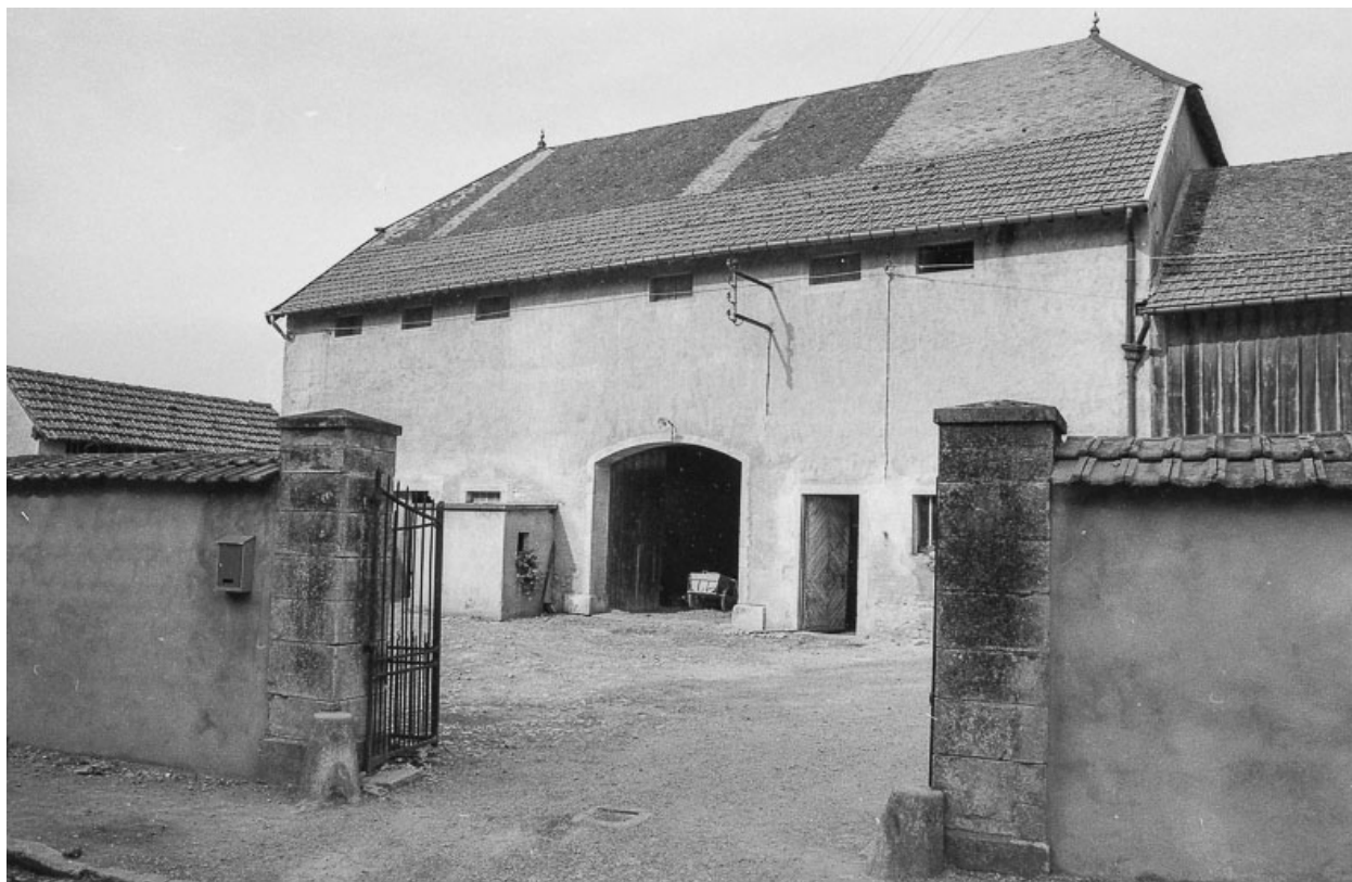
Bâtiment agricole dans la cour de gauche.
