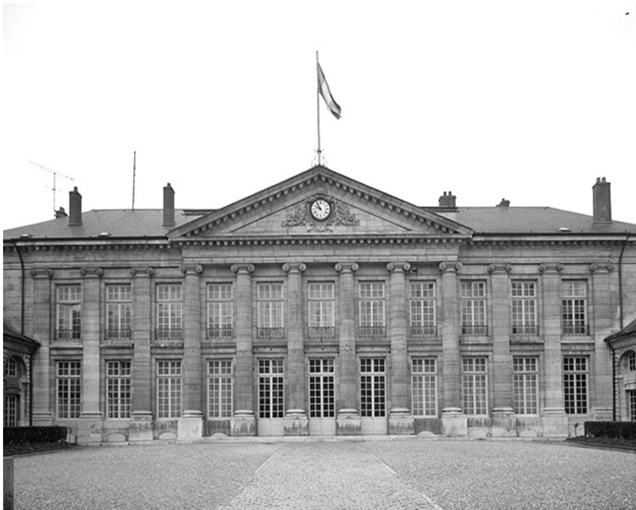
Façade antérieure, de face.
