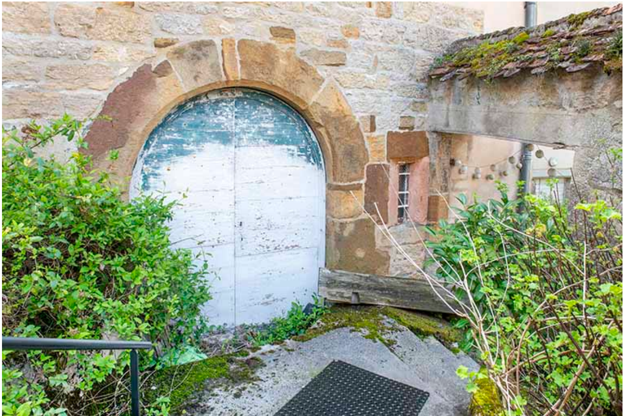
Porte de cave (façade nord).
