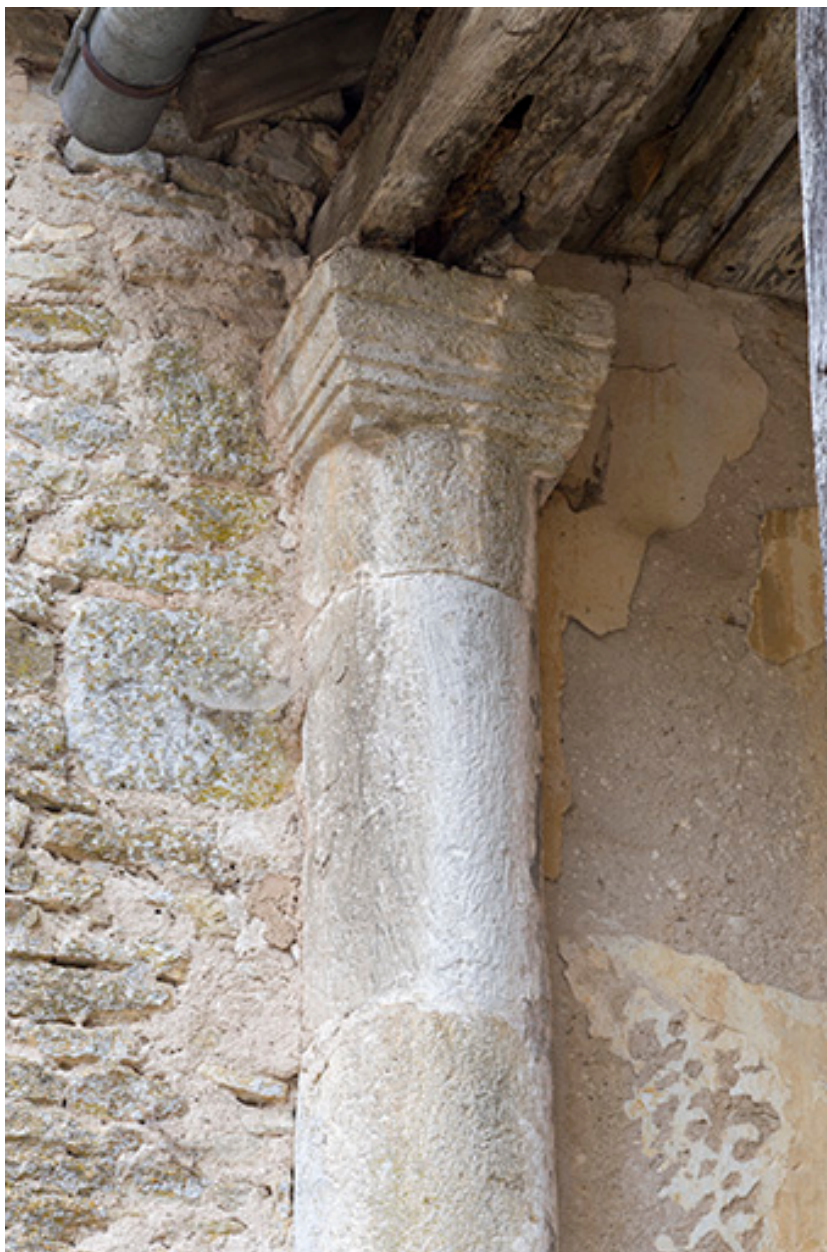
Colonne adossée au mur du premier palier.
