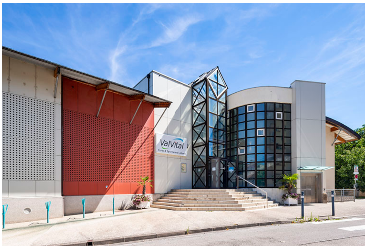
Piscine de l'extension de 1983 (à gauche).
