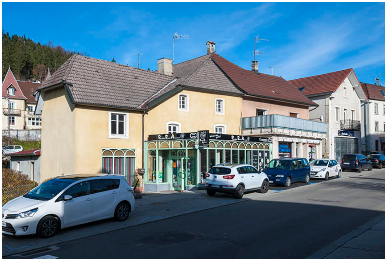
Vue d'ensemble, depuis le sud-ouest (façade antérieure).
