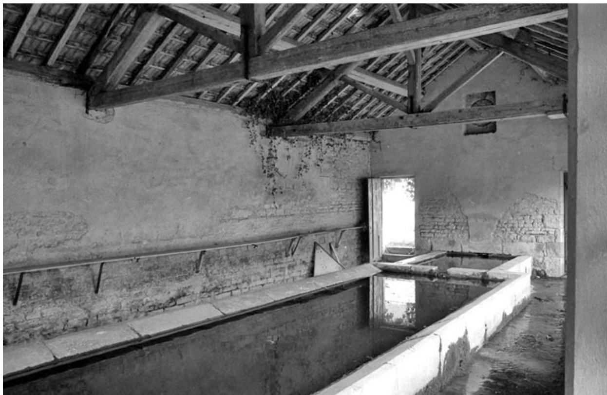
Vue intérieure du lavoir.
