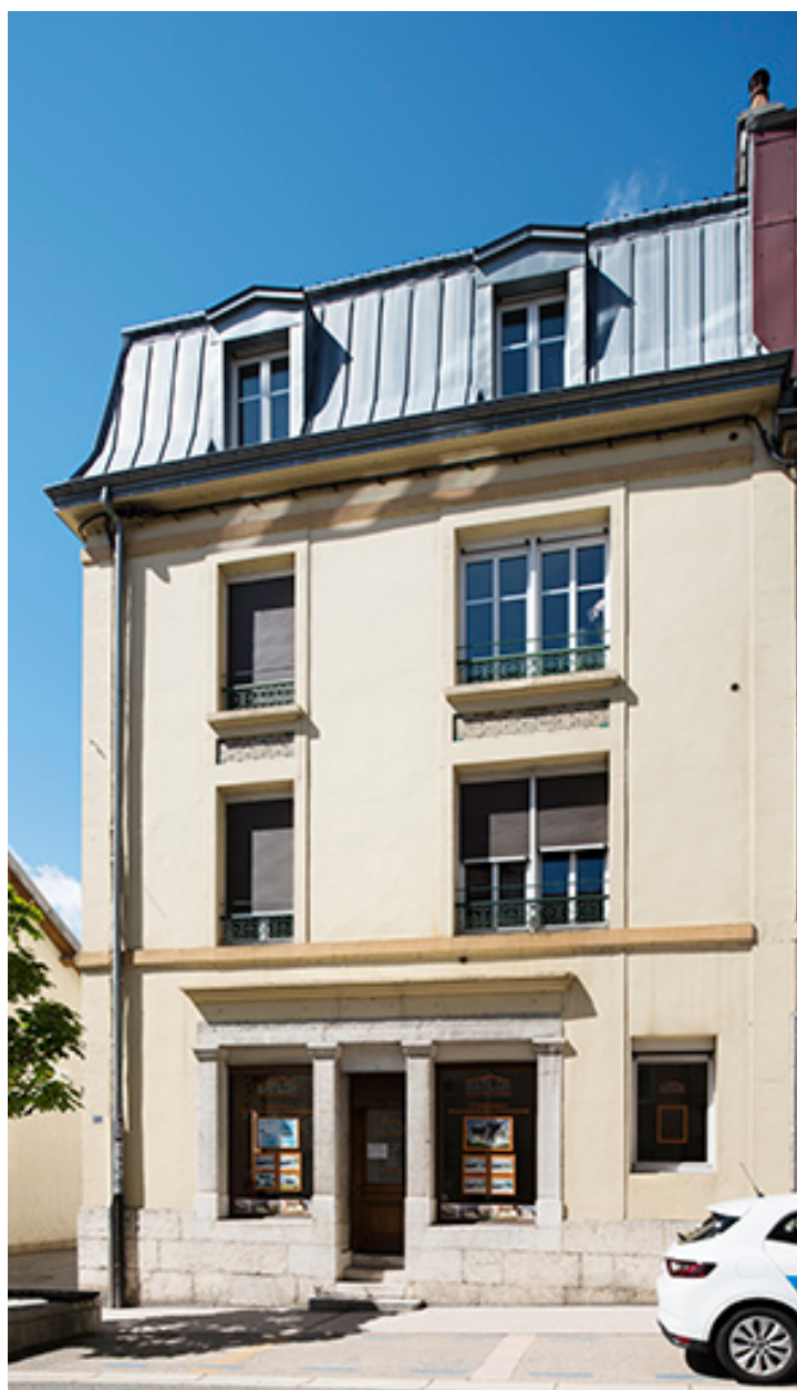
Partie gauche (5 bis) de la façade antérieure.
