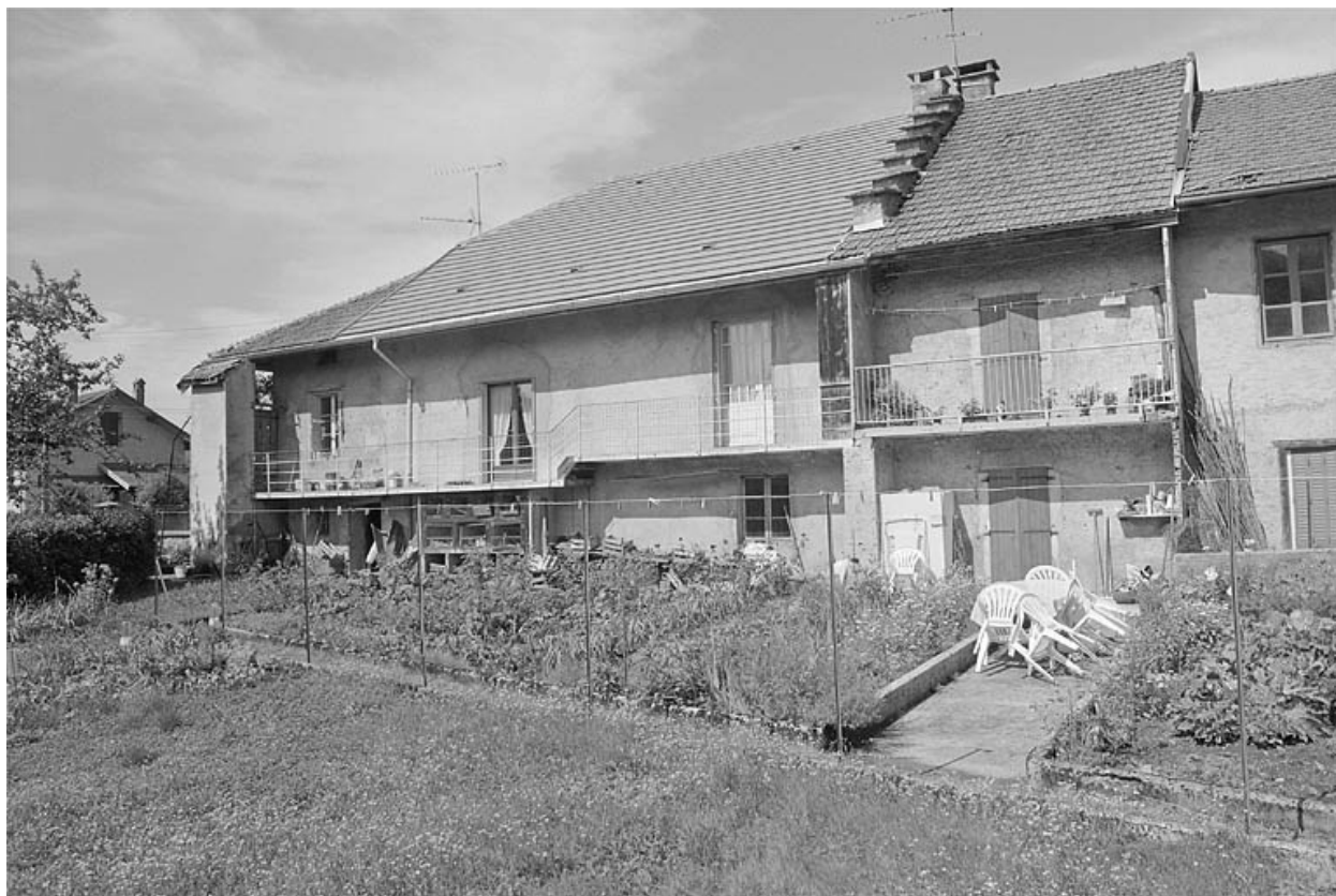
Façade postérieure de la ferme.
