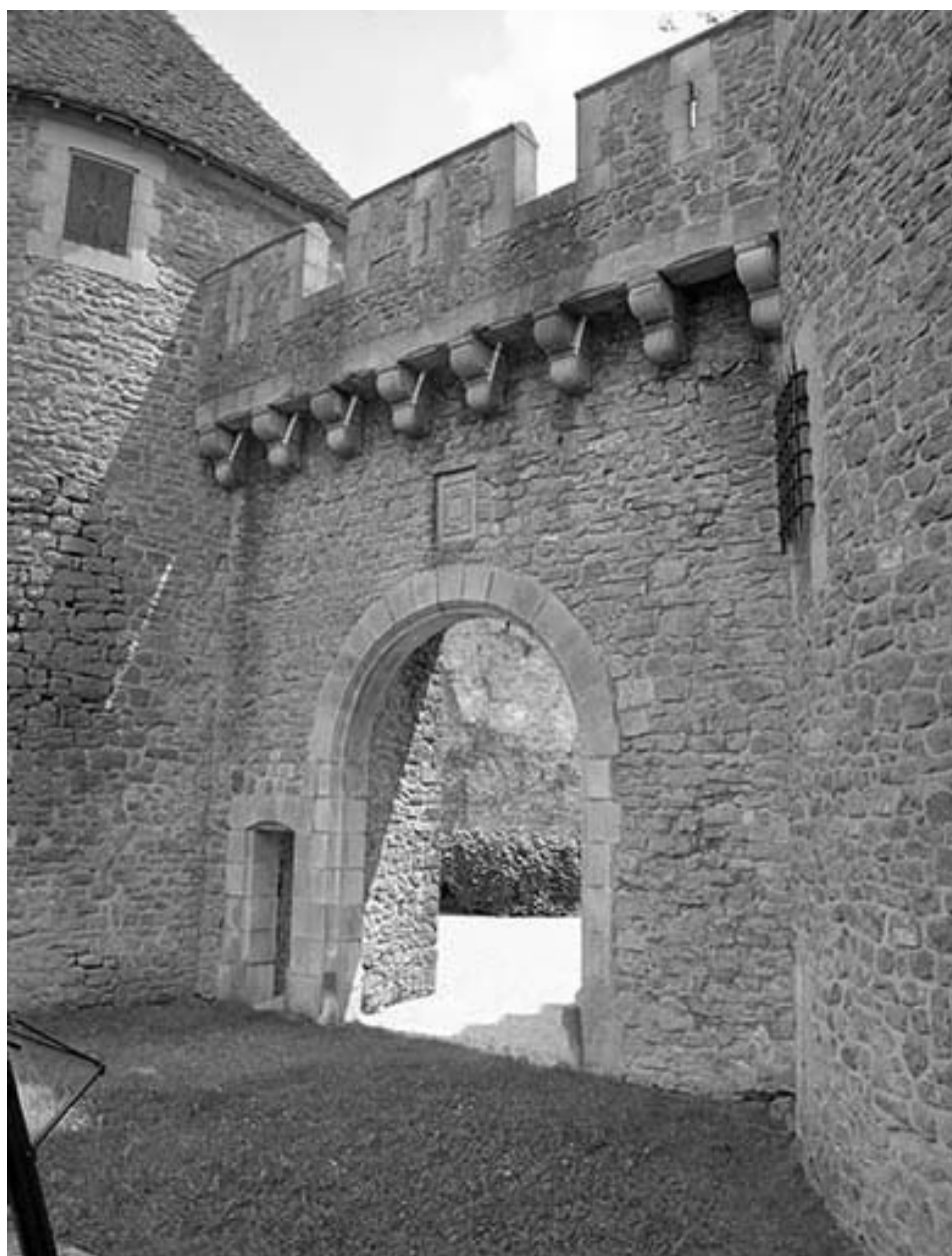
Portail nord : vue de trois quarts.
