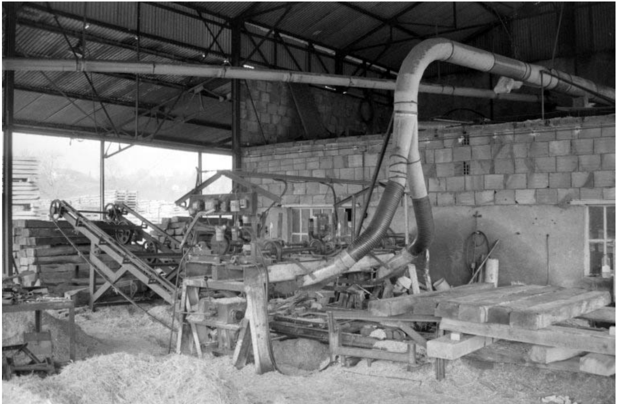
La machine à apprêter les traverses.
