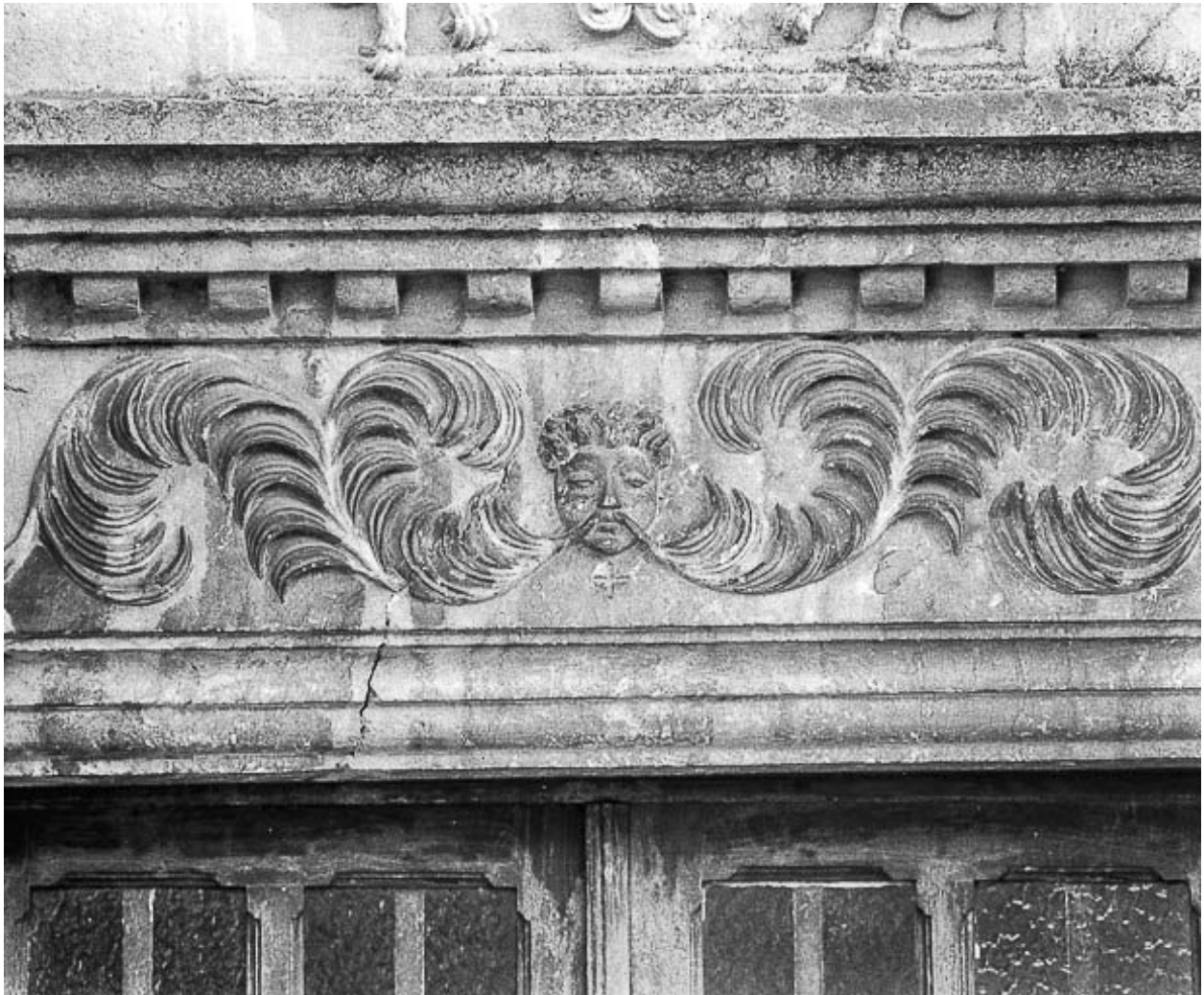
Linteau de la porte d'entrée.
