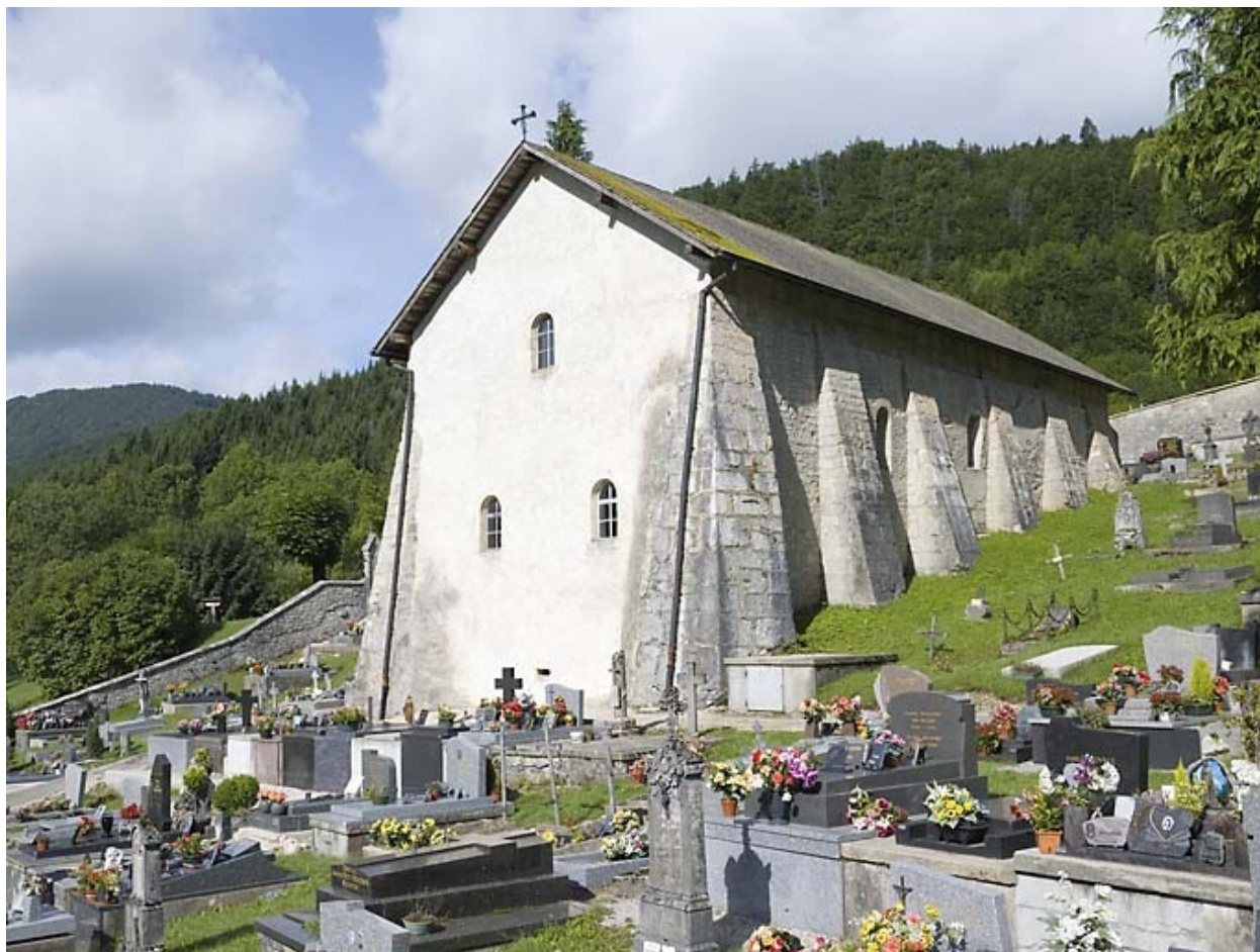
Vue générale rapprochée, depuis le sud-est.
