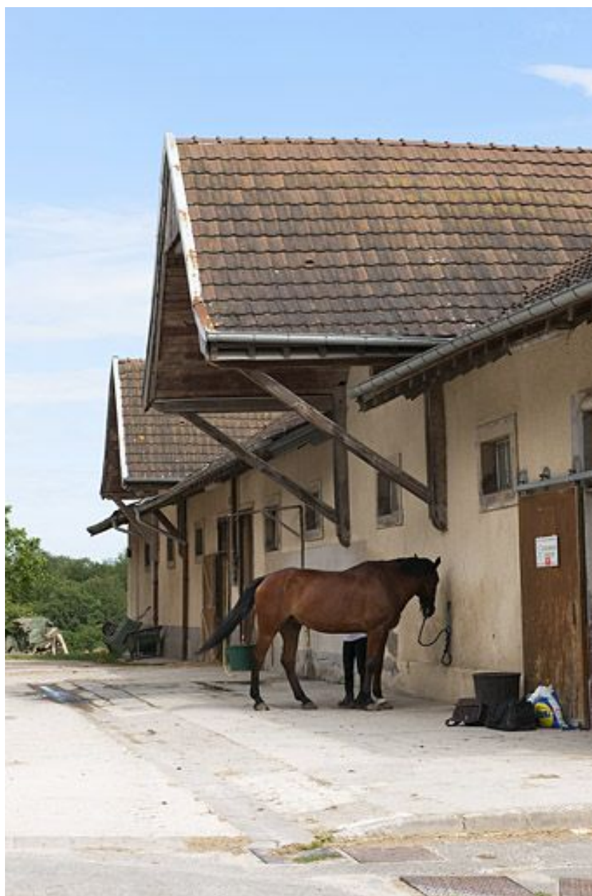
Ancienne étable. Vue de trois quarts.
