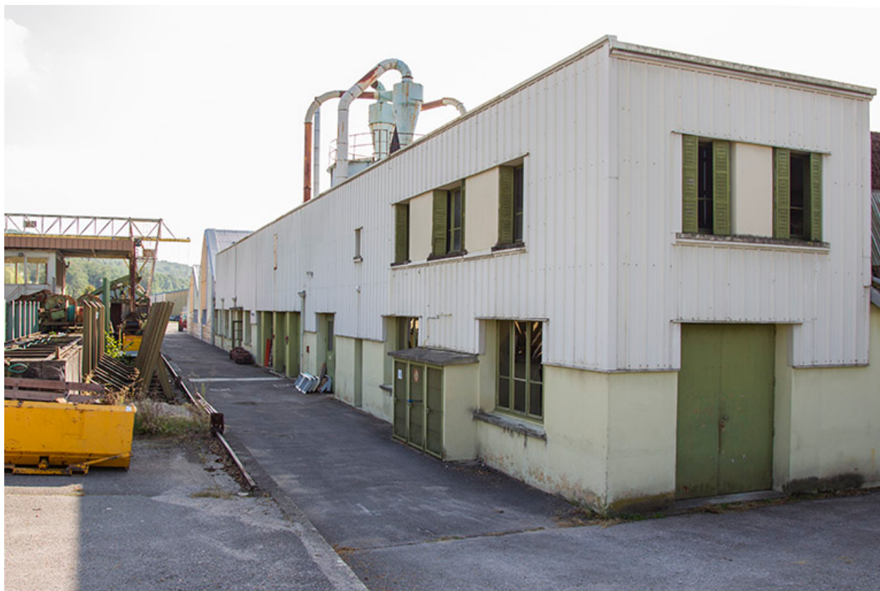
Atelier construction : façade antérieure.
