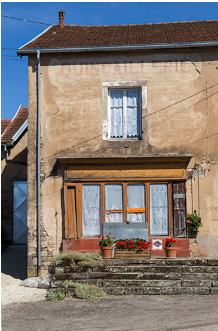
Ancienne boutique, rue de la Forge.
