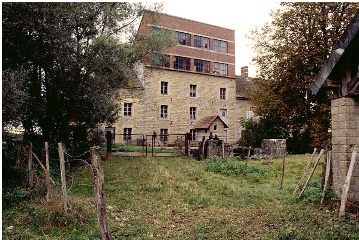
Façade antérieure depuis l'est.
