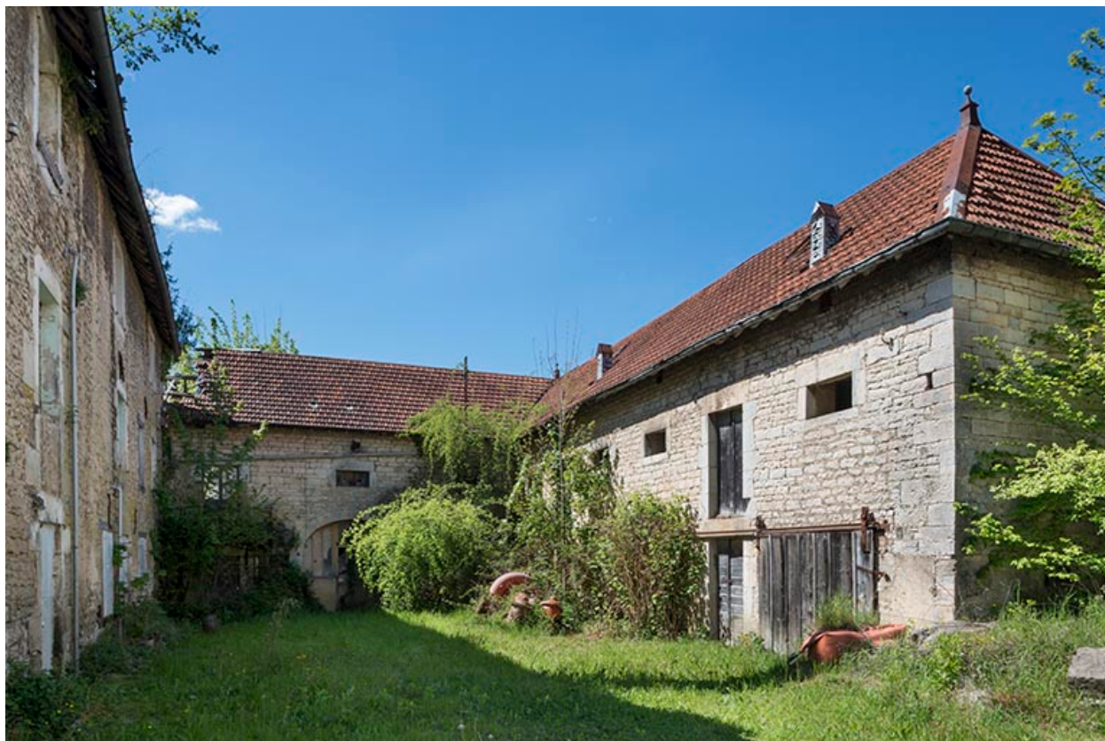
Remise et écurie.
