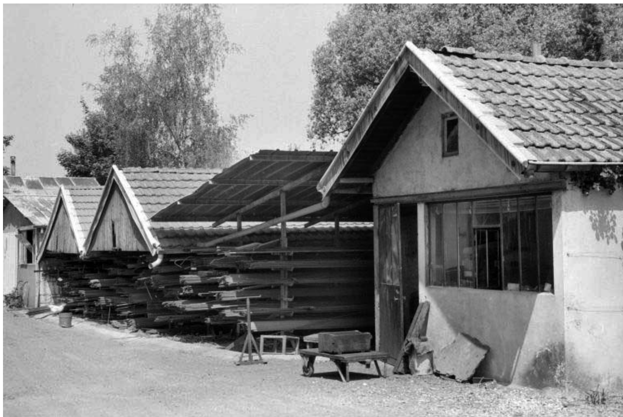
Ancienne remise et entrepôts industriels.
