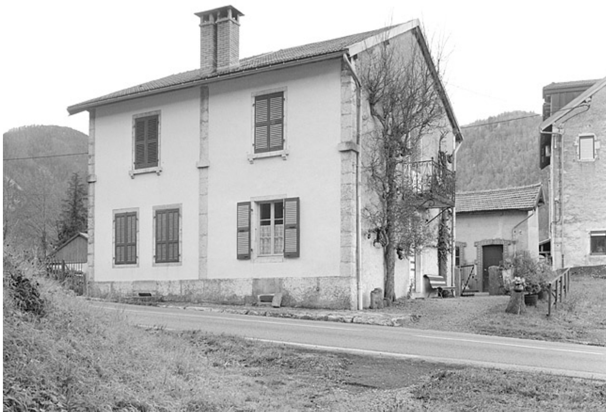
Maison jumelée à Villard-Saint-Sauveur.
