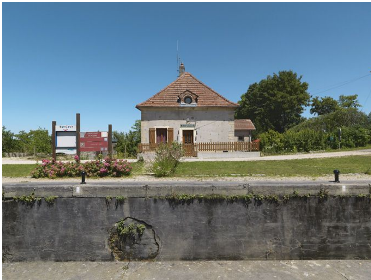
Maison éclusière vue de face.
