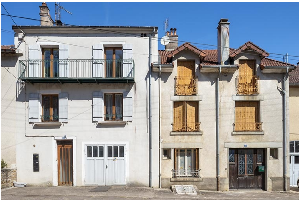
Rue Thiers, façades des maisons n° 31 et 33.
