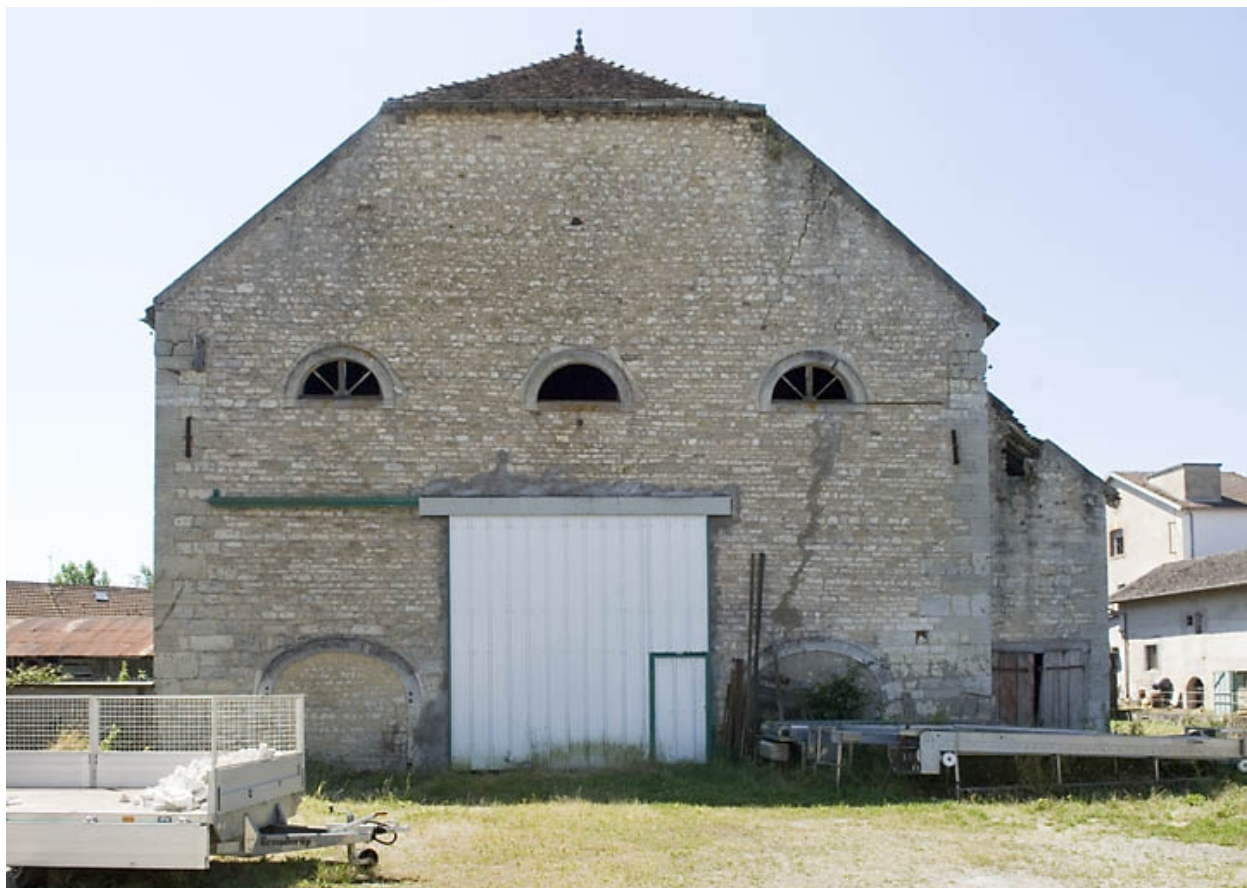
Mur-pignon nord du haut fourneau.
