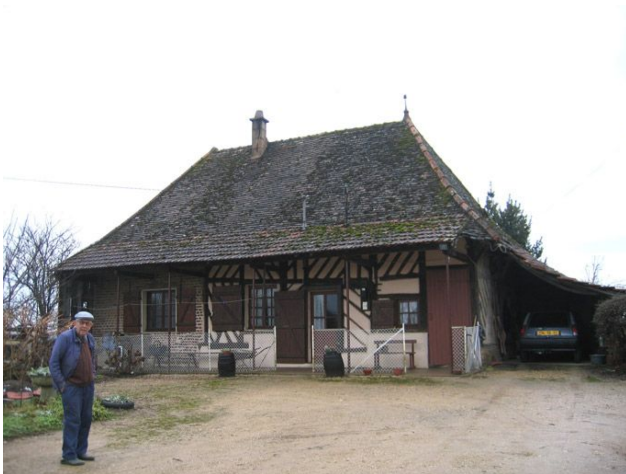
Vue d'ensemble de la façade.
