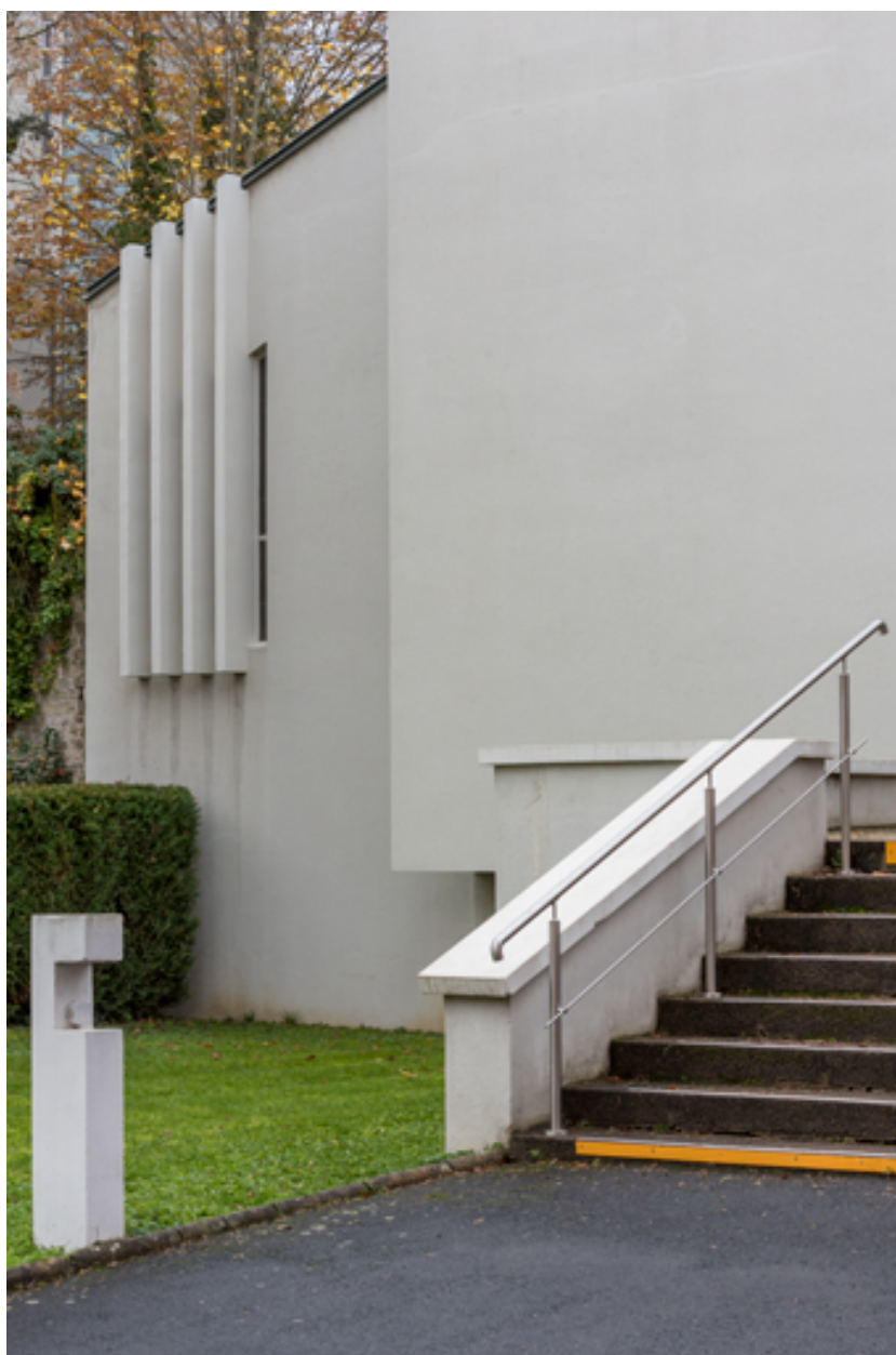
Détail de la façade est.
