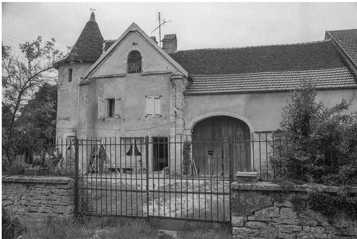
Façade antérieure depuis la cour.
