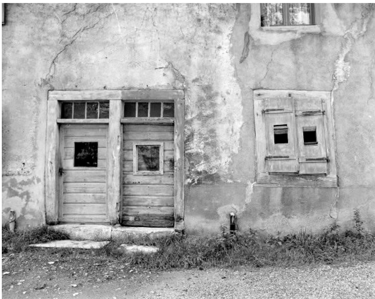
Façade postérieure : détail.
