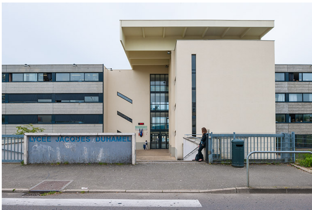
Entrée principale sur rue Charles Laurent Thouverey.
