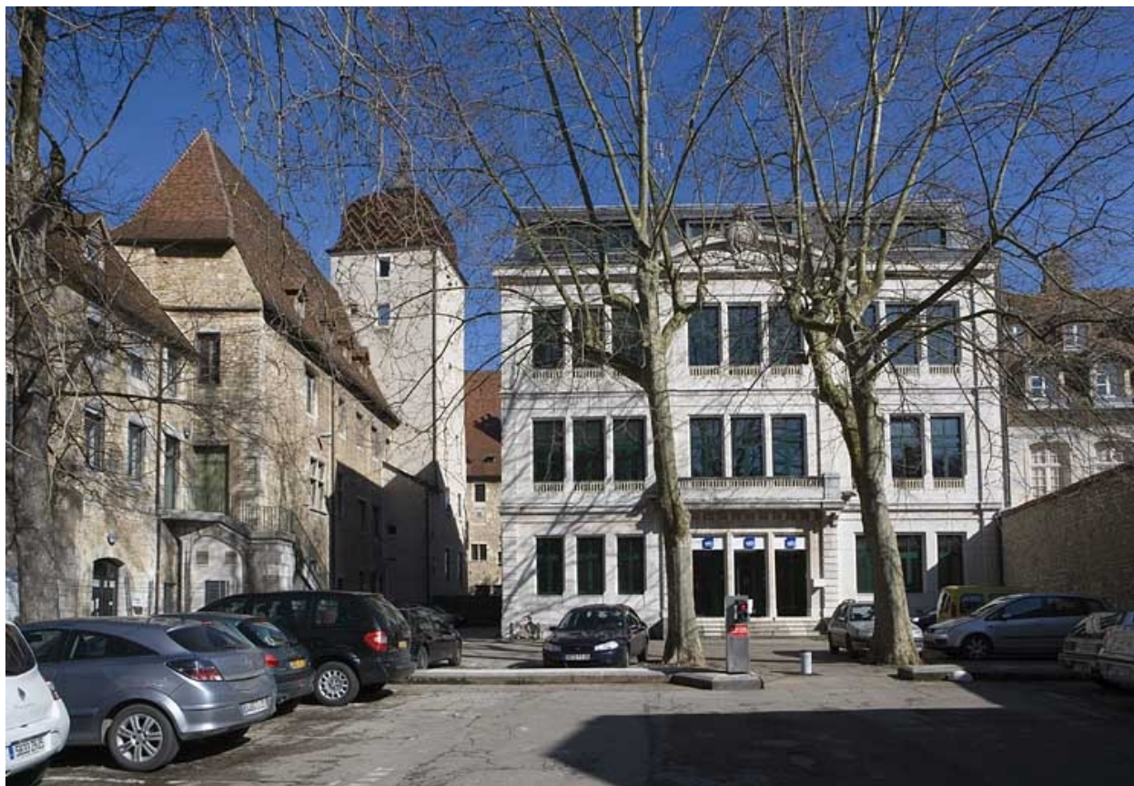
Vue d'ensemble, de face.
