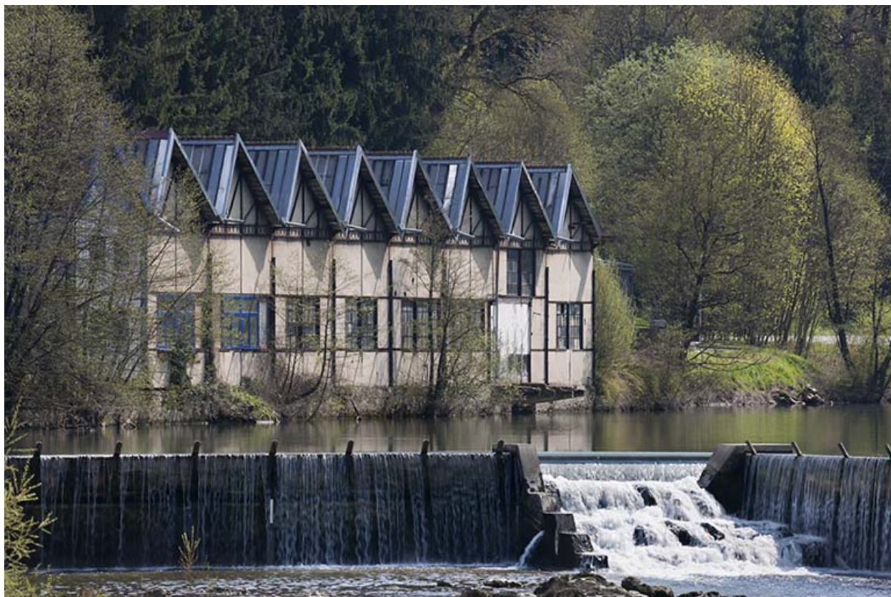
Ateliers sud de la rive droite.
