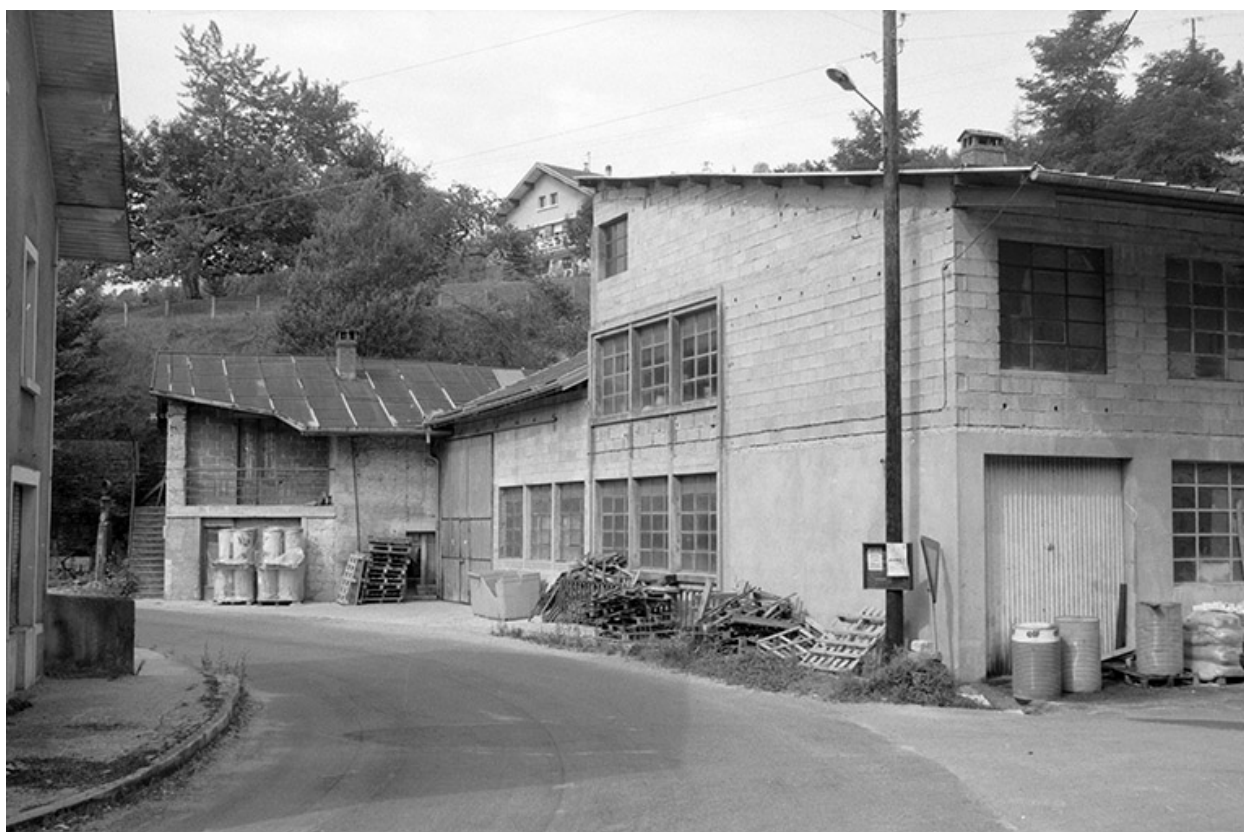
Bâtiments récents (H, I, J).
