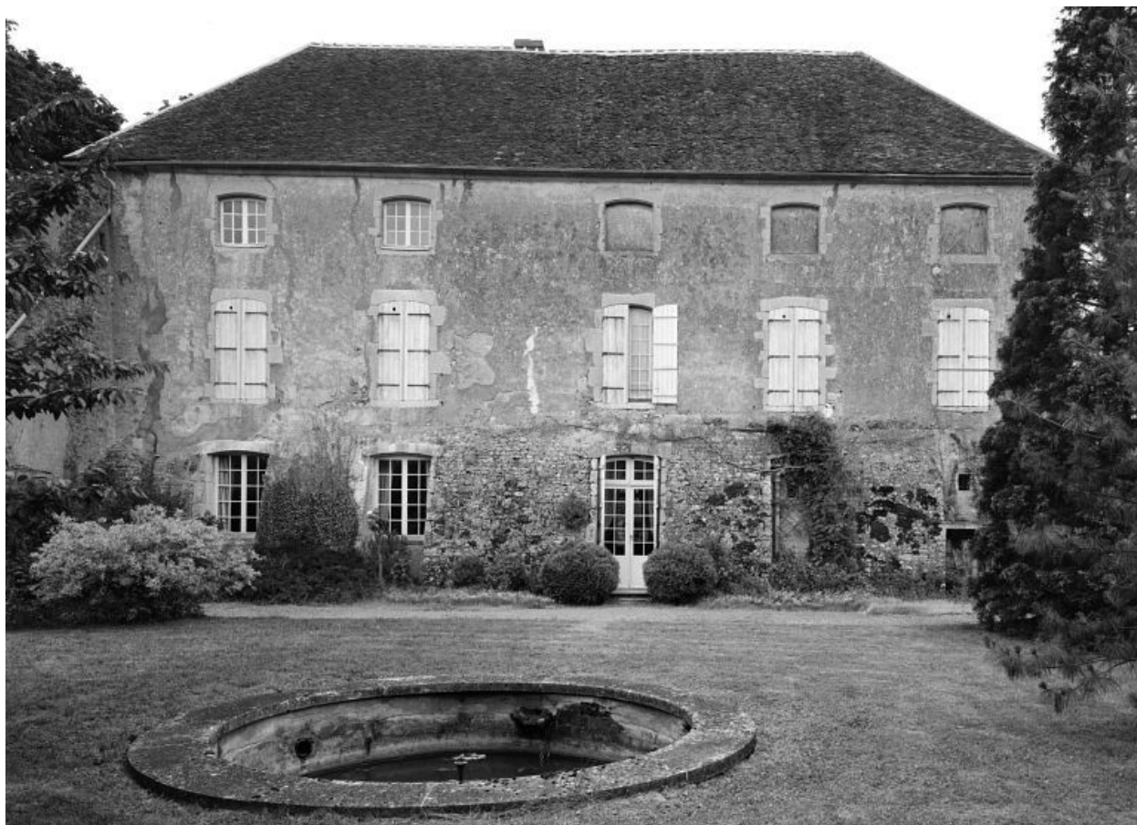
Bâtiment sud-ouest. Elévation antérieure.
