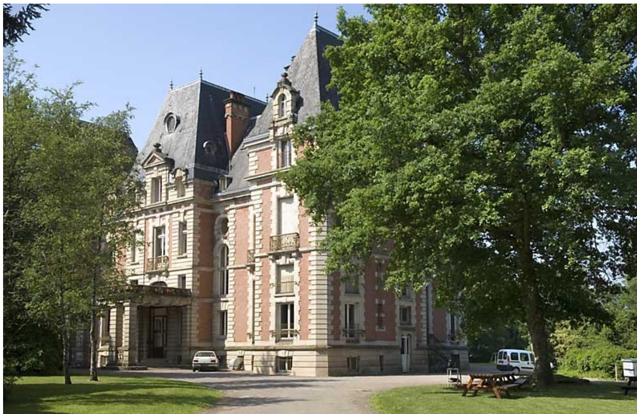
Logement patronal. Vue de trois quarts.
