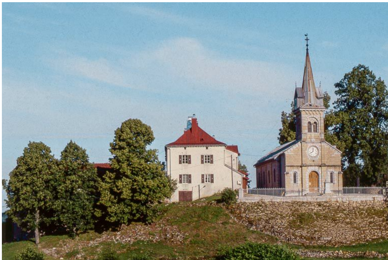
Vue éloignée du presbytère et de l'église.
