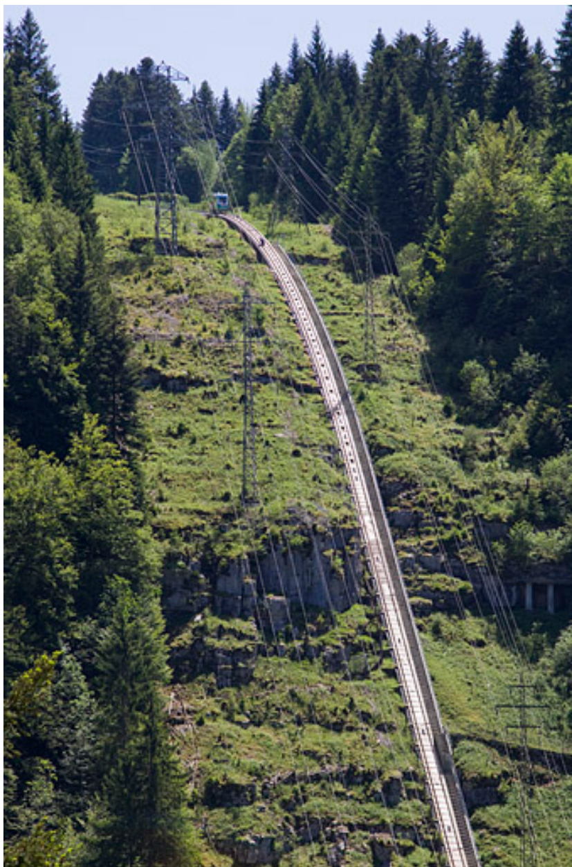
Centrale du Châtelot : vue rapprochée du funiculaire.
