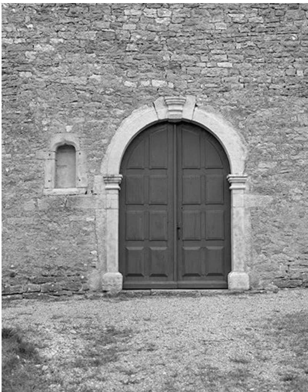
Portail de la façade antérieure.
