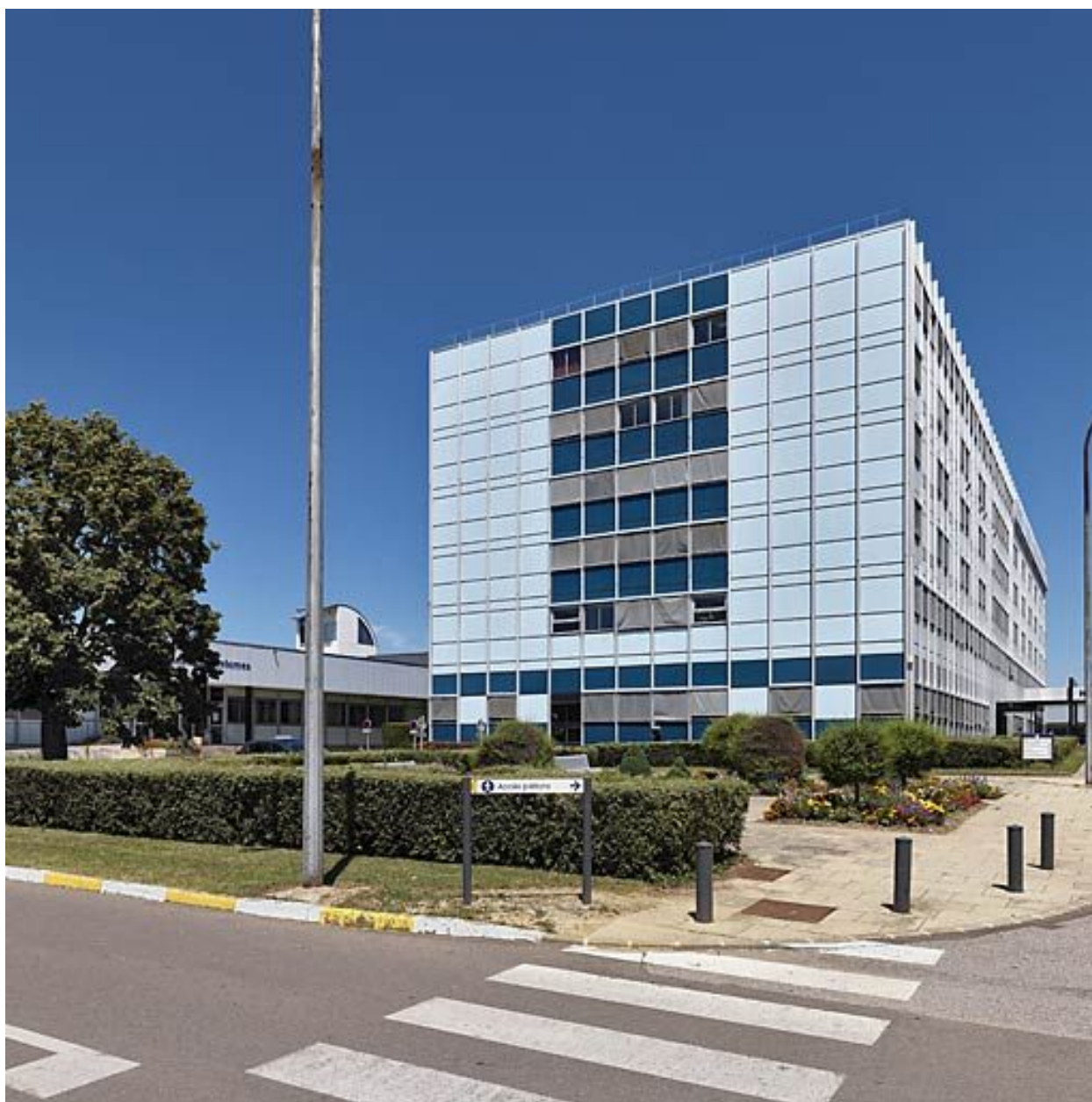
Bâtiment principal, vue d'ensemble de trois-quarts.
