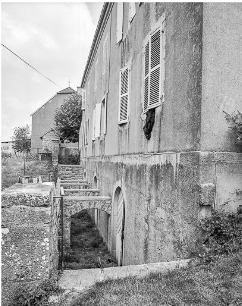
Détail du soubassement de la façade postérieure.
