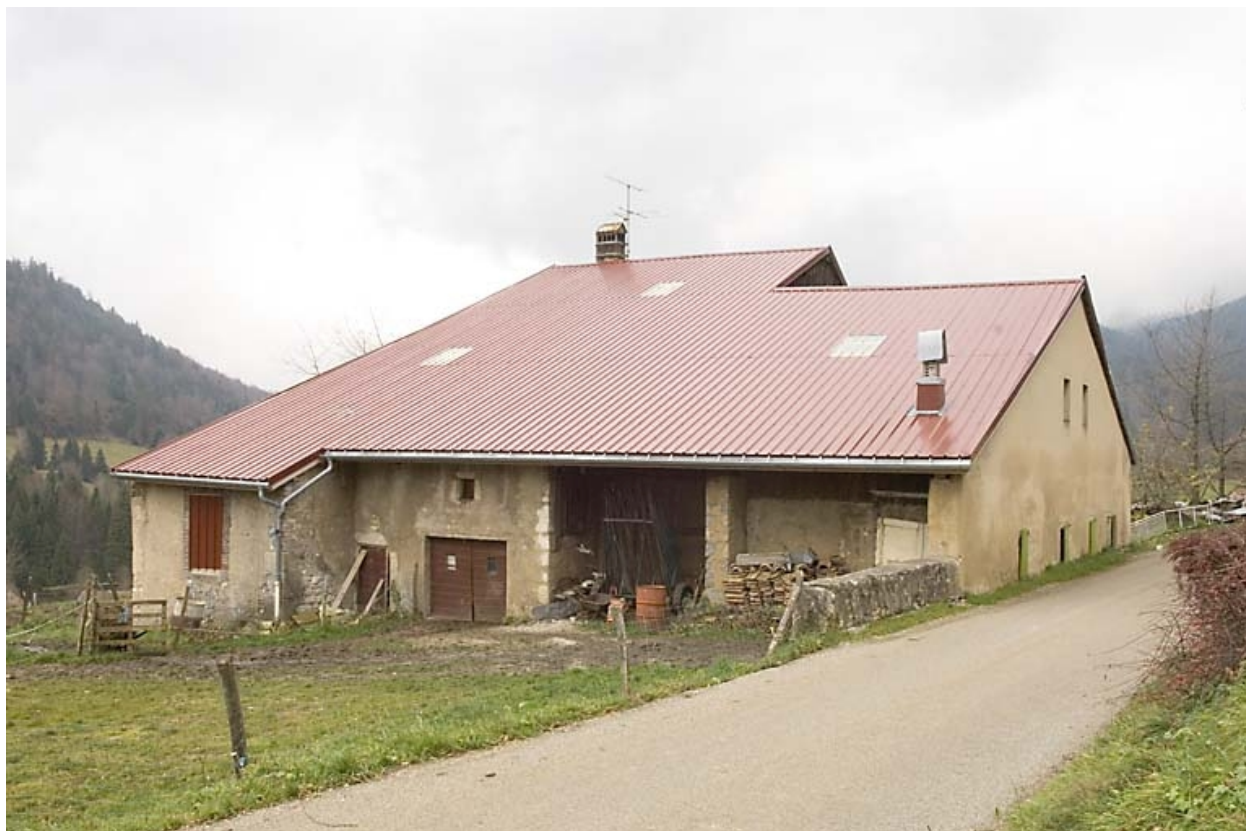
Façades nord et ouest.
