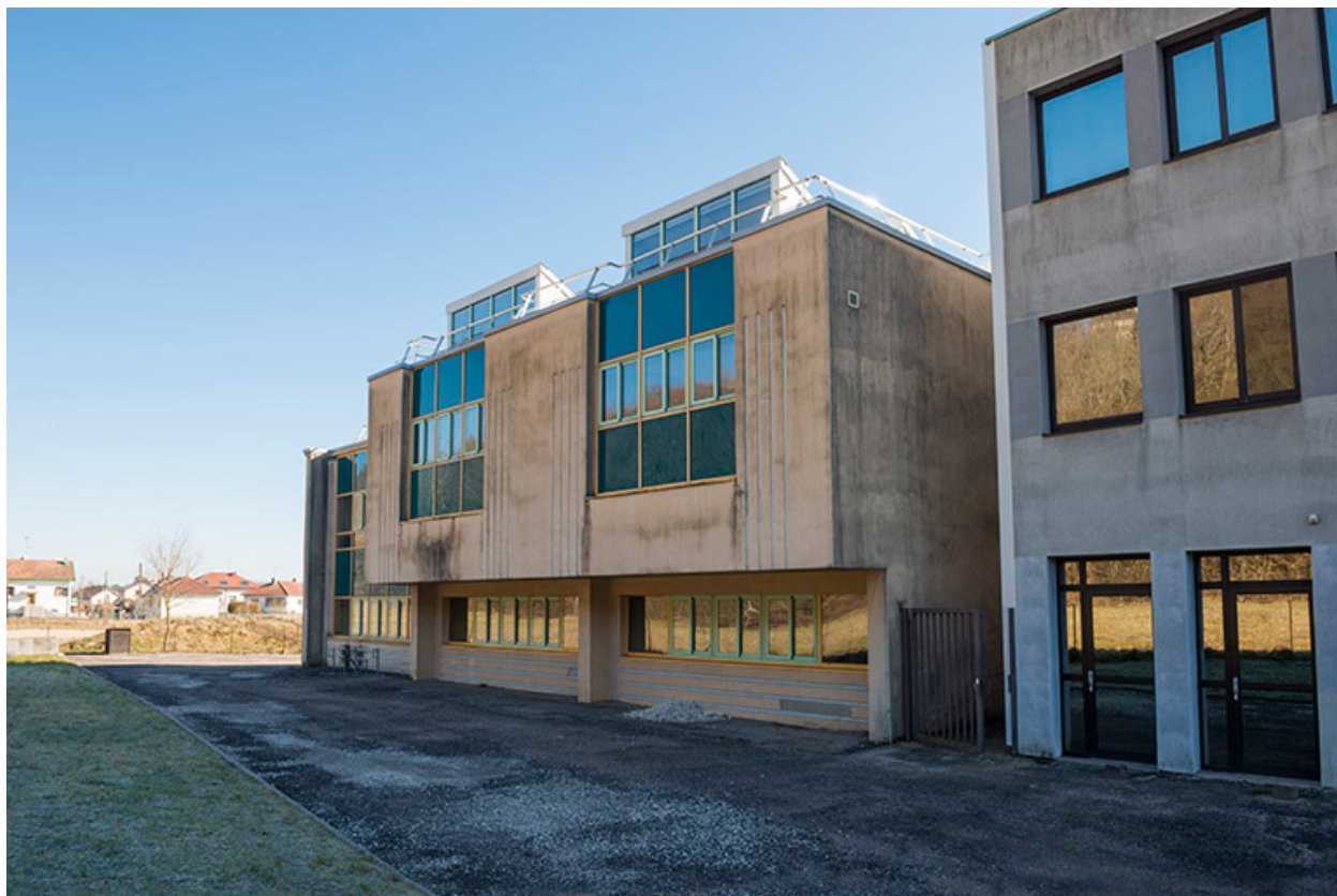
Façade ouest de l'externat nord.
