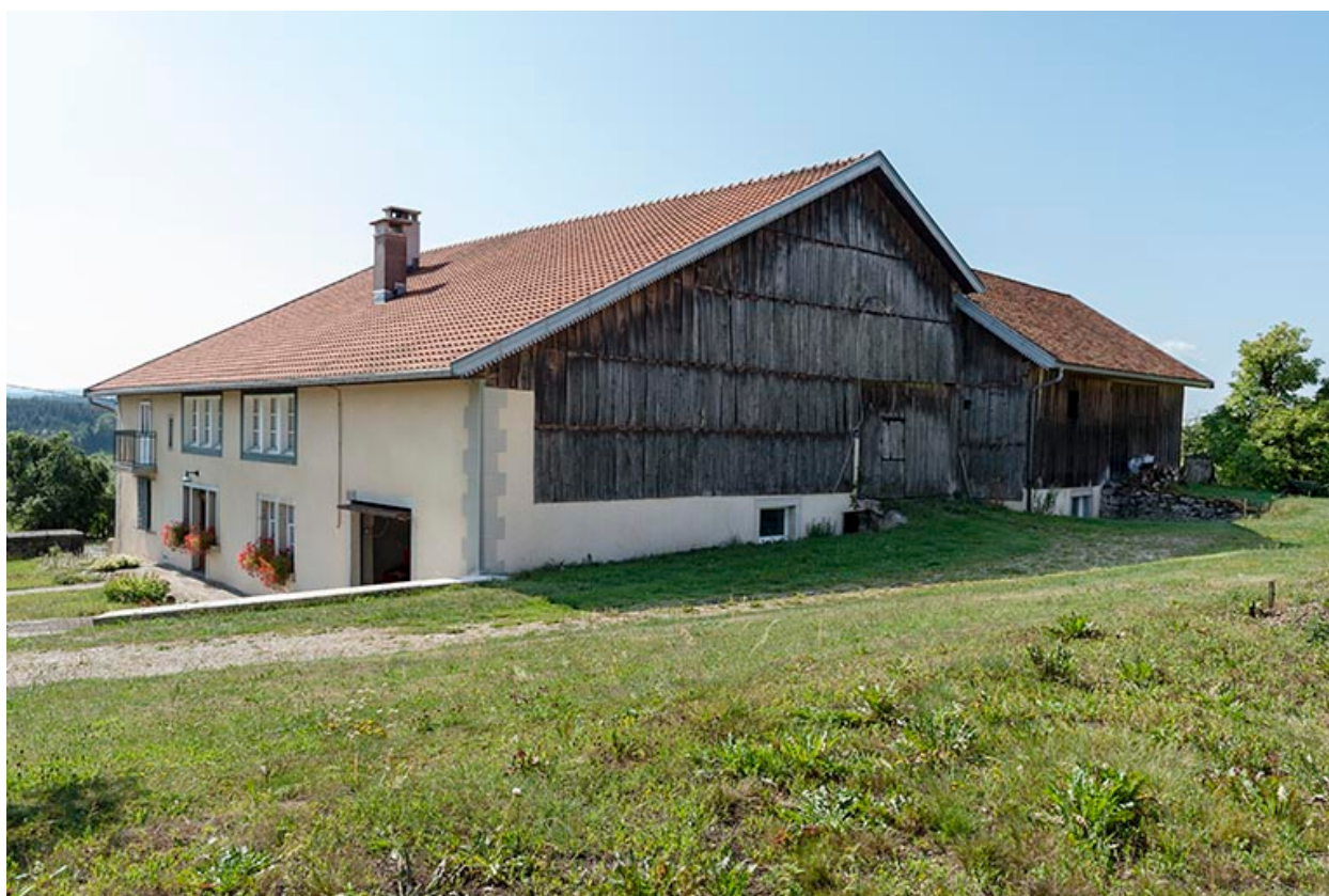
Façades antérieure et latérale droite.
