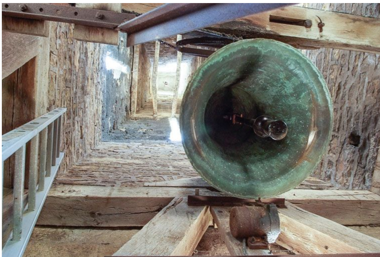
Vue depuis le plancher du beffroi.
