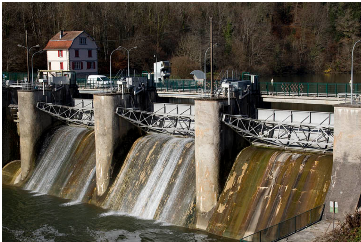
Barrage depuis la rive gauche en aval.
