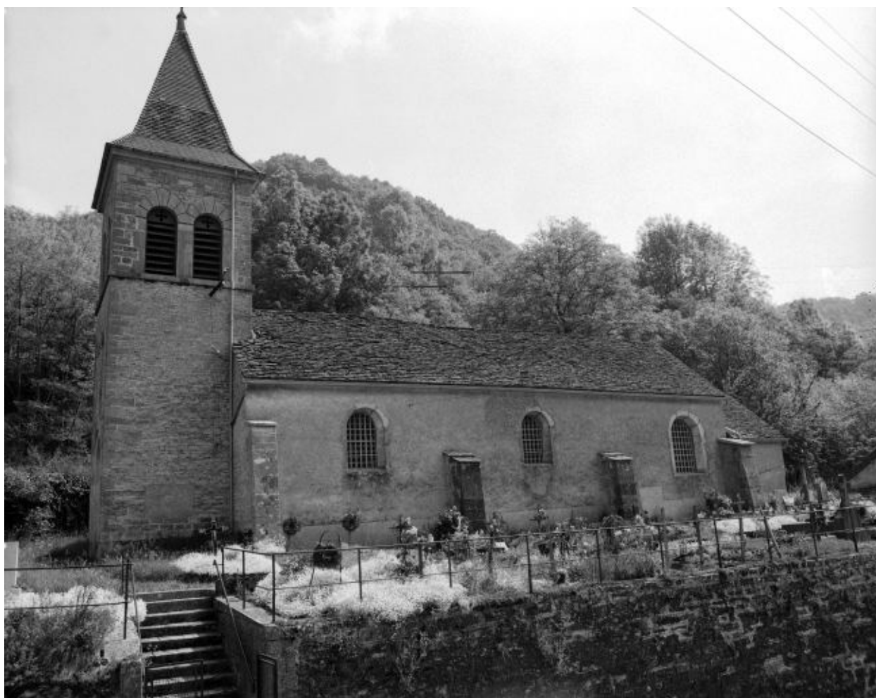
Façade latérale droite.
