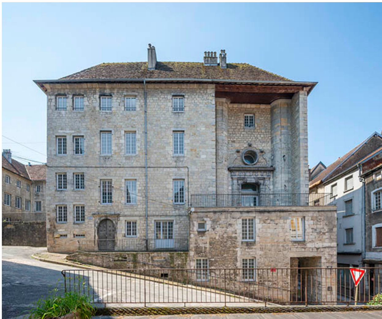
Façade nord du bâtiment sur rue.
